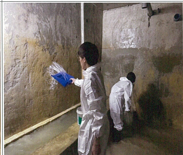
ภาพที่ 58 ล้างถังเก็บน้ำดีสำรอง
