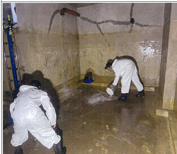
ภาพที่ 58 ล้างถังเก็บน้ำดีสำรอง
