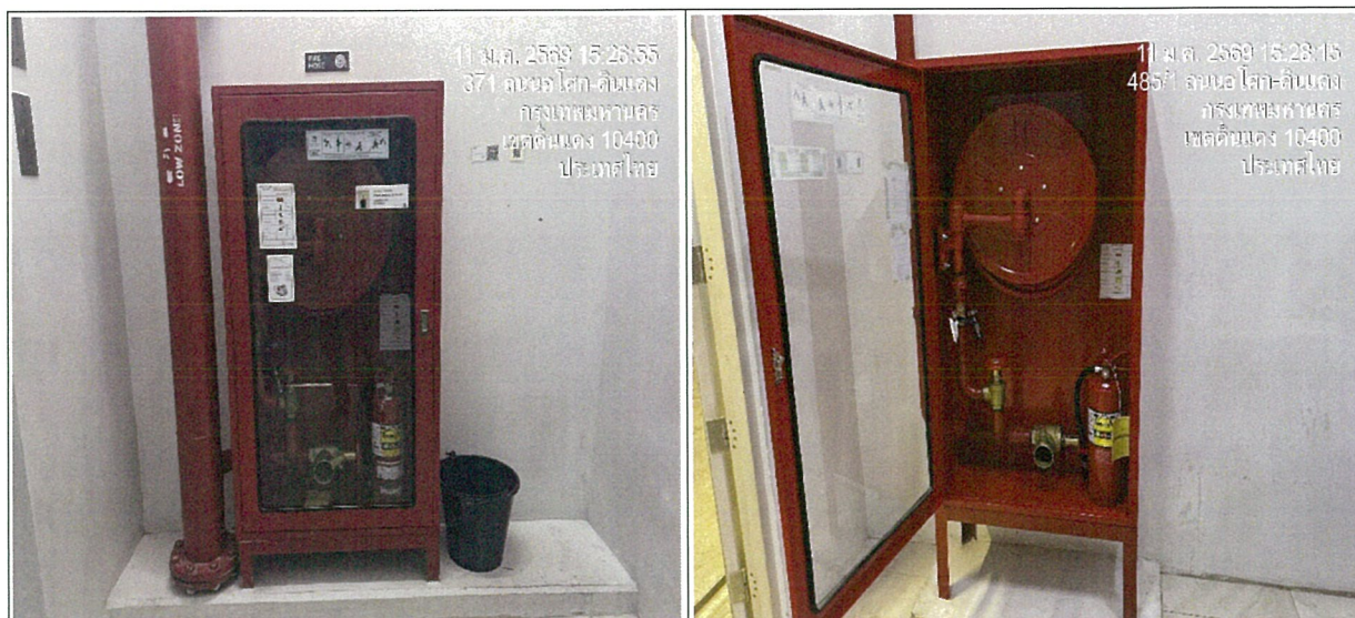
ภาพที่ 33 ตู้เก็บสายฉีดน้ำดับเพลิงพร้อมอุปกรณ์
